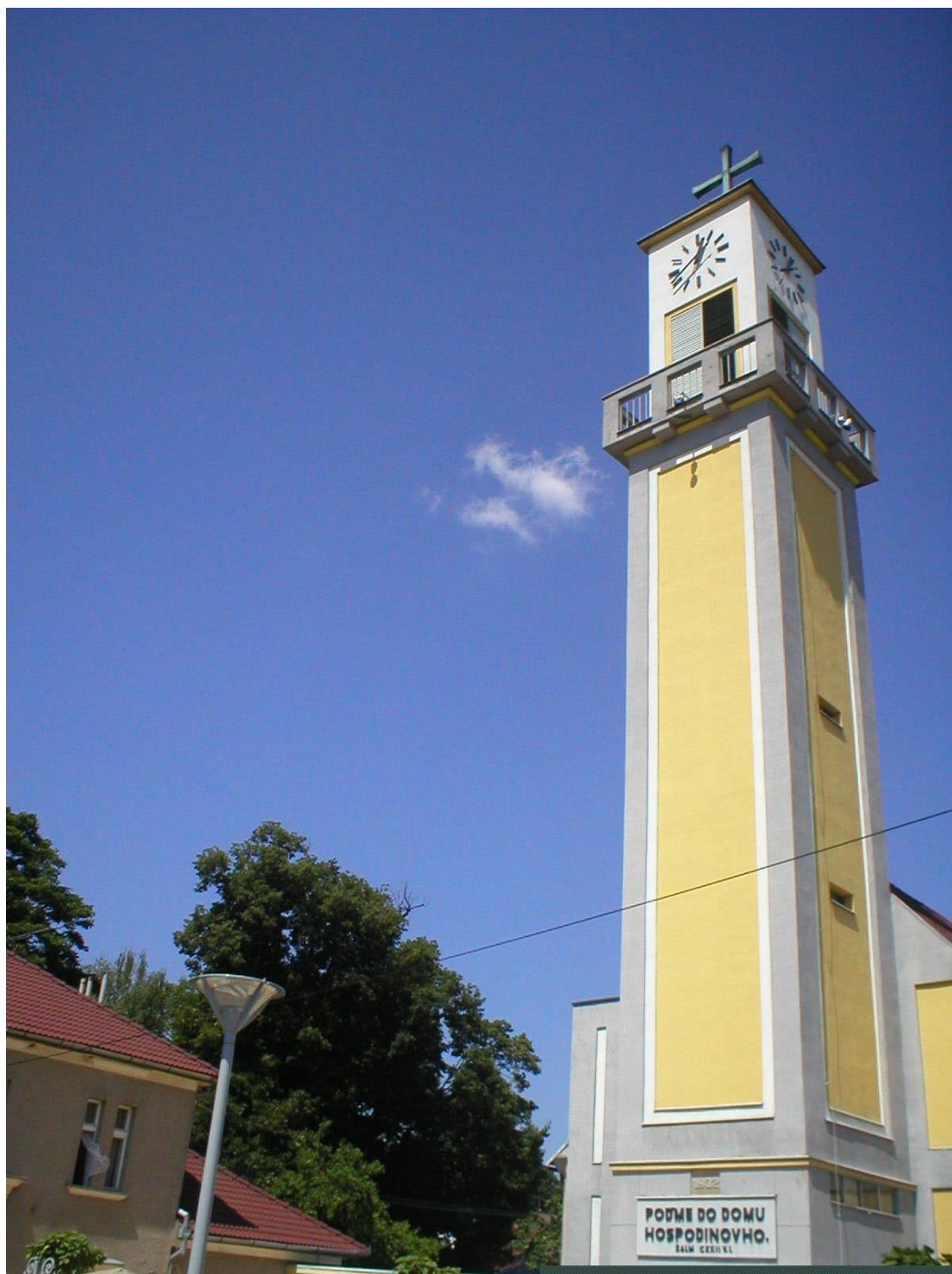
Evanjelický kostol z r. 1784, k barokovej lodi prístavba funkcionalistickej veže z r.1932 architekti J. Merganc a O. Klimeš
