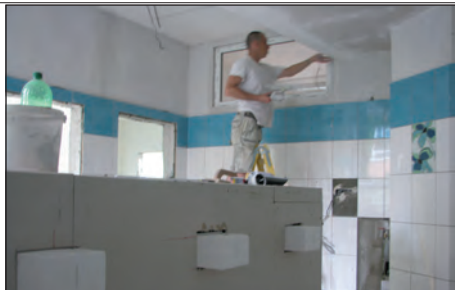
V auguste stavenisko, od nového školského roka nová trieda MŠ na „štvorke“.
