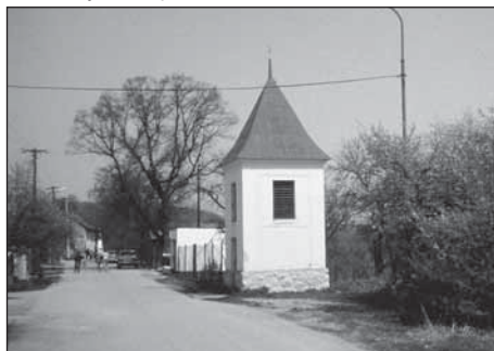
Zvonica a prístupová cesta k bývalému prievozu cez Váh
