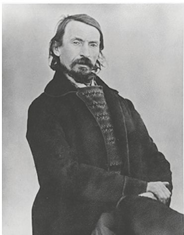
Turej Lúke a v Brezovej pod Bradlom.
