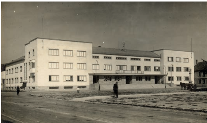
Reprezentačná stavba mesta – budova Okresného a Mestského úradu (v súčasnosti budova Nemocnice s poliklinikou)
