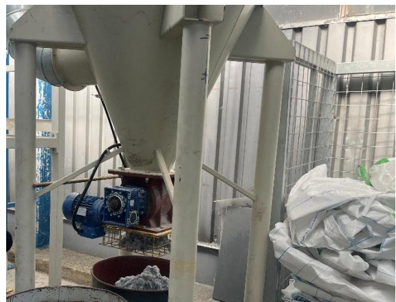
FOT. 4 Pohľad na čerpadlo
