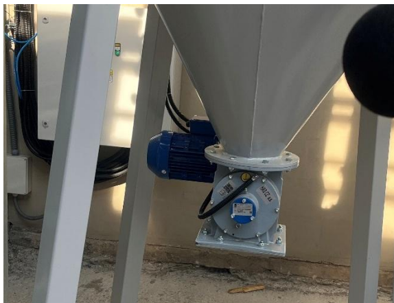
FOT. 10 Pohľad na čerpadlo
