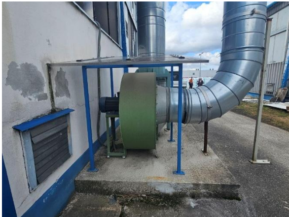
FOT. 7 Pohľad na čerpadlo
