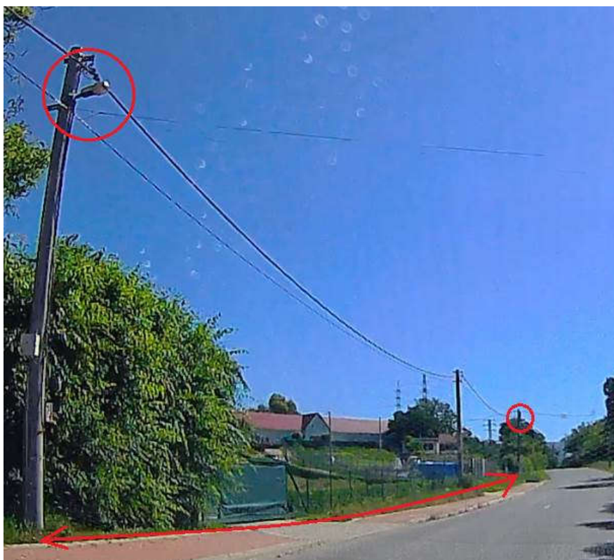
Obr. 15 Veľké rozostupy medzi svietidlami – vzdialenosť okolo 60 - 65 m medzi stožiarmi - Ulica Tehelná
