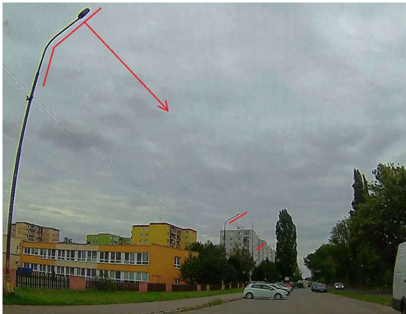
Obr. 16 Zlý uhol vyloženia
