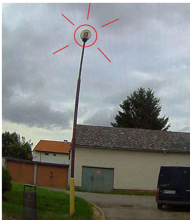
Obr. 18 Nevhodné umiestnenie svietidla na osvetlenie chodníka – Vnútrobloky
