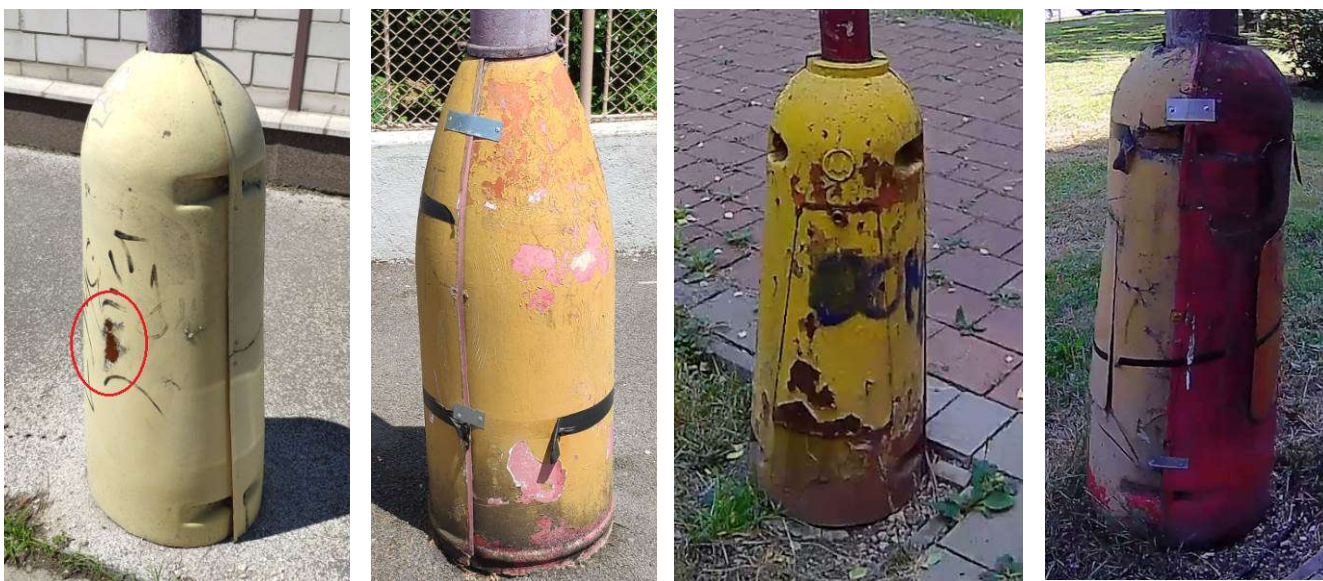
Obr. 10 Prepáskované, deravé, rozbité, nezatesnené pätky stožiarov
