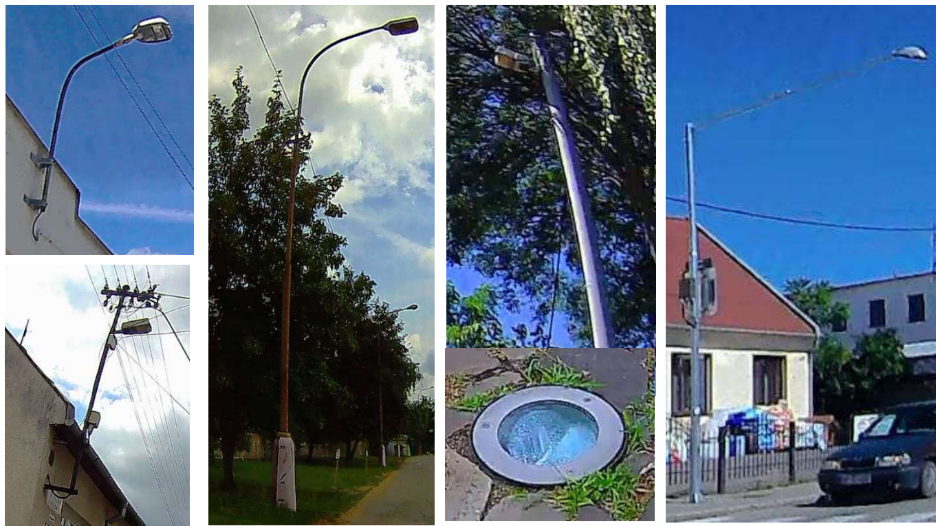
Obr. 4 Svietidlá na rôznych stožiaroch: oceľový stožiar – betónový stožiar – svietidlo na nástrešníku – svietidlo na fasáde – svietidlo na prechodovom stožiar
