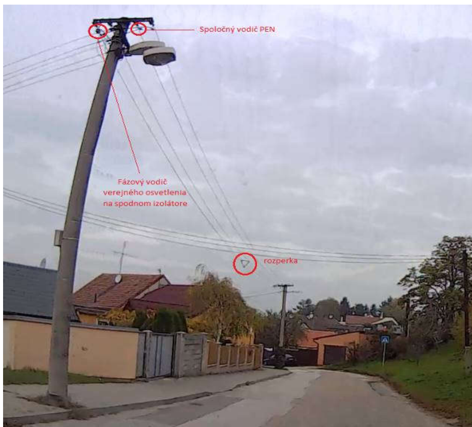
Obr. 14 Holé vzdušné vedenie typu AIFe 25
