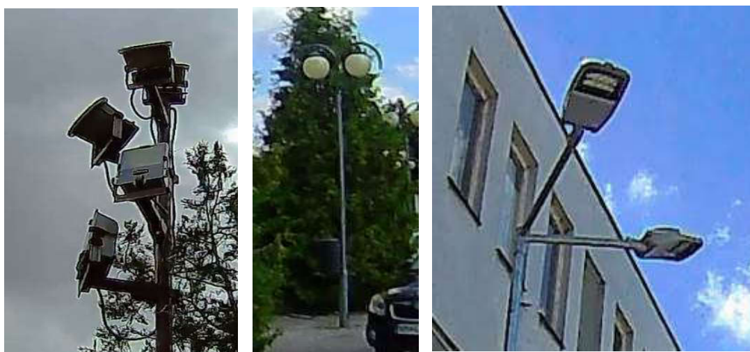
Obr. 5 Päť / dve svietidlá na oceľovom stožiar
