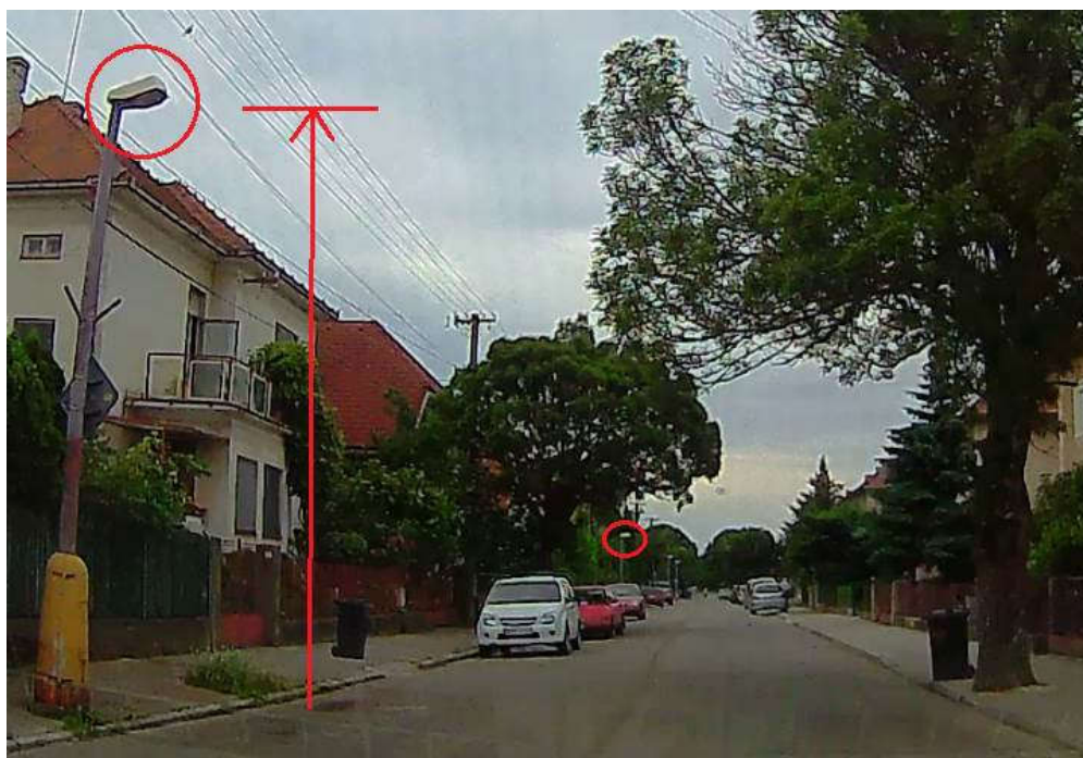
Obr. 17 Veľké rozostupy medzi svietidlami, zlá geometria sústavy, nerovnomernosť osvetlenia, vzdialenosť okolo 40 m medzi stožiarimi, svietidlá na nízkych skorodovaných stožiaroch
