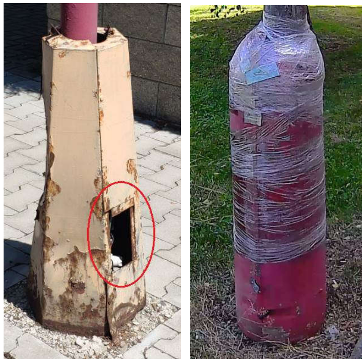
Obr. 11 Stožiarová elektrovýzbroj, skorodované, nestabilné krytie elektrovýzbroja, voľne dostupné živé časti, zoxidované kontakty
