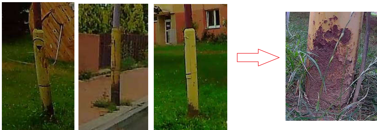
Obr. 9 Silne skorodované stožiare na rôznych miestach - hrozba pádu stožiara
